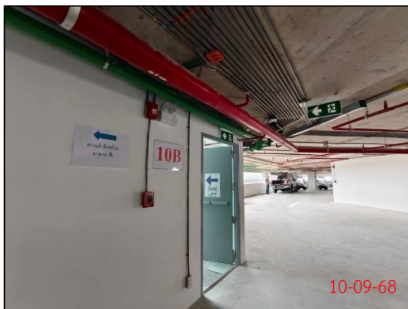
ชุดแจ้งเหตุเพลิงไหม้ ป้ายบอกทางหนีไฟ และประตูหนีไฟ ในอาคารผู้ป่วยนอก (OPD)-จอดรถ และบริการโครงการ
