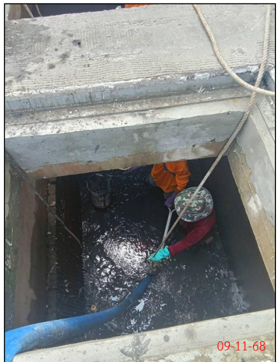
ทำความสะอาดชุดลอกบ่อพักน้ำฝน
