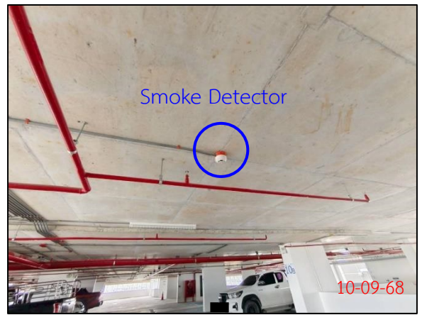
เครื่องตรวจจับควันบริเวณที่จอดรถภายในอาคาร ผู้ป่วยนอก (OPD)-จอดรถ และบริการโครงการ
