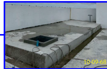
ถังเก็บน้ำบริเวณชั้นดาดฟ้า ความจุ 39.83 ลบ.ม.
