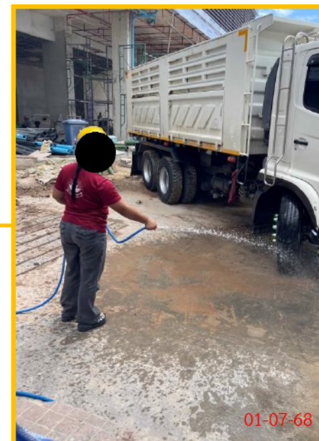
พื้นที่ล้างล้อรถก่อนออกนอกพื้นที่ก่อสร้าง
