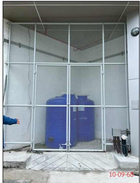
ถังบำบัดก๊าซมีเทน และ Aerosol จากระบบบำบัดน้ำเสีย ของอาคารผู้ป่วยนอก (OPD)-จอตรถ และบริการโครงการ
